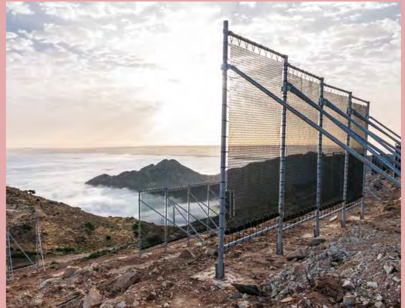
Nebelkollektoren mit verschiedenen Netzmaterialien und ausgestattet mit Messgeräten im Anti-Atlasgebirge in Südwestmarokko zur Trinkwassergewinnung.
