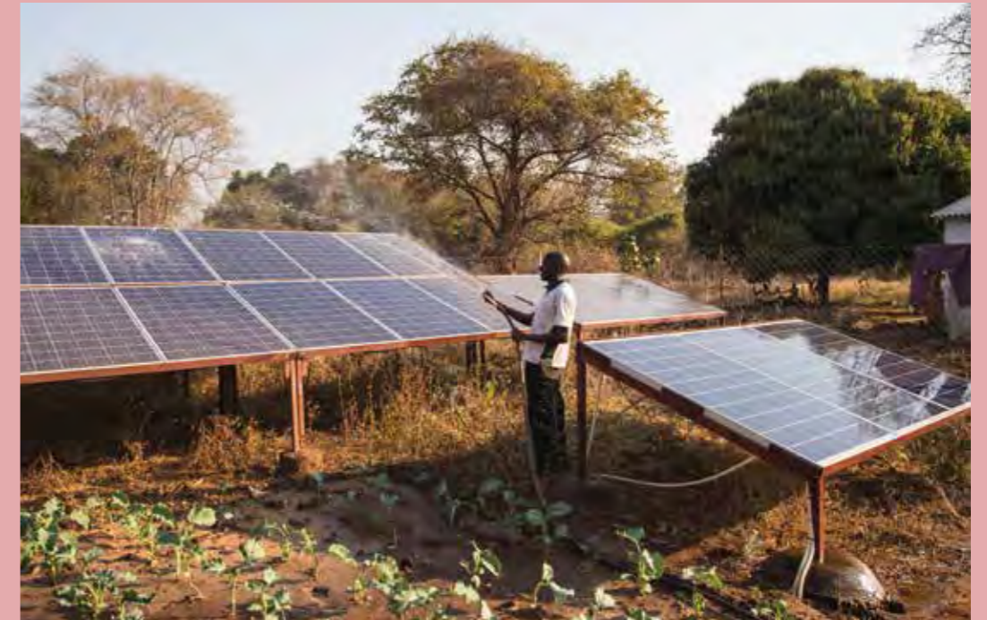
Regelmäßige Reinigung und Wartung einer Photovoltaik-Anlage in Simbabwe (Afrika).
