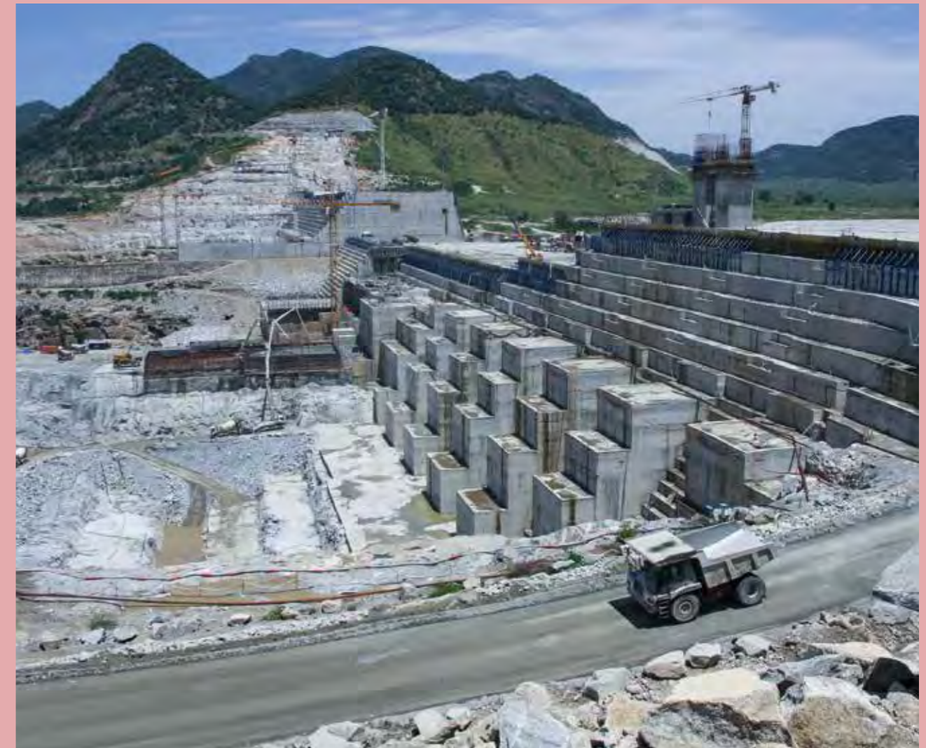
Bau des Grand Renaissance Damms in Äthiopien, der größten Wasserkraftanlage Afrikas.
